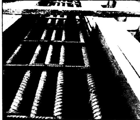
Imagen 1 y 2. Armadura y encofrado de pilote adicional eje 33.
